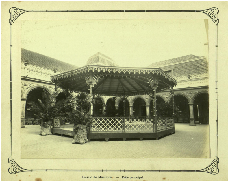
Palacio de Miraflores. — Patio principal.
